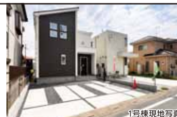
1号棟現地写真
