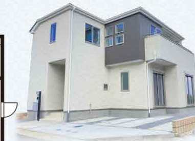
※10号棟現地写真
