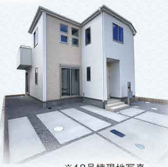
※18号棟現地写真
